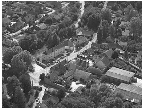
Letecký pohled na Echenon s dominantní budovou radnice.
